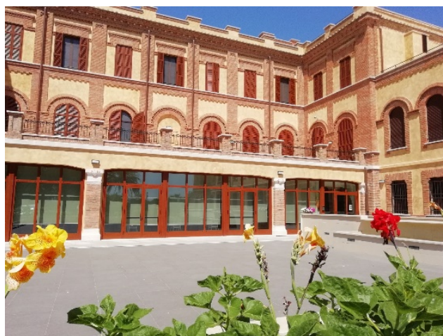
Maison de Rome côté cour, restaurée.
